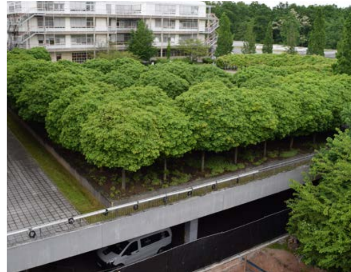
Abb. 52 Dachwald auf der Tiefgarage des Klinikums Nürnberg Süd © BuGG Bundesverband GebäudeGrün e.V.
