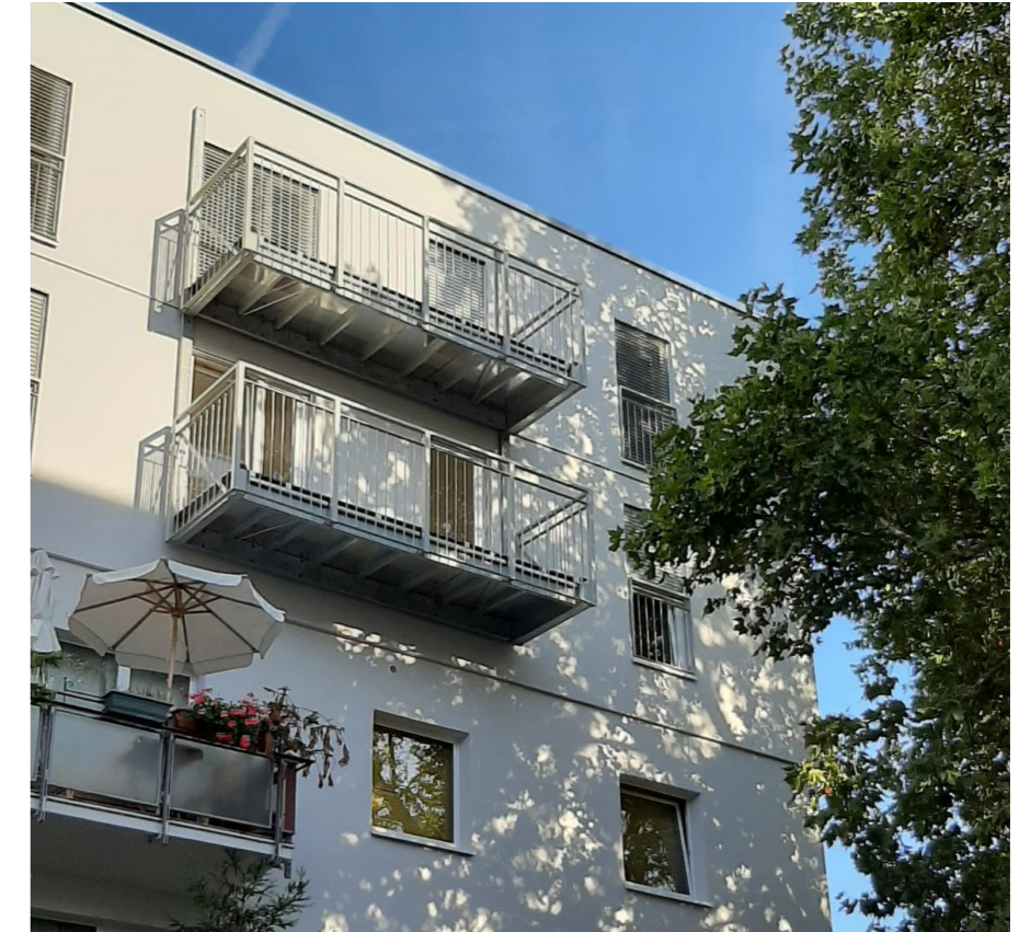
Abb. 49 Aufstockung der Platensiedlung in Frankfurt © LiWood Holzmodulbau AG
