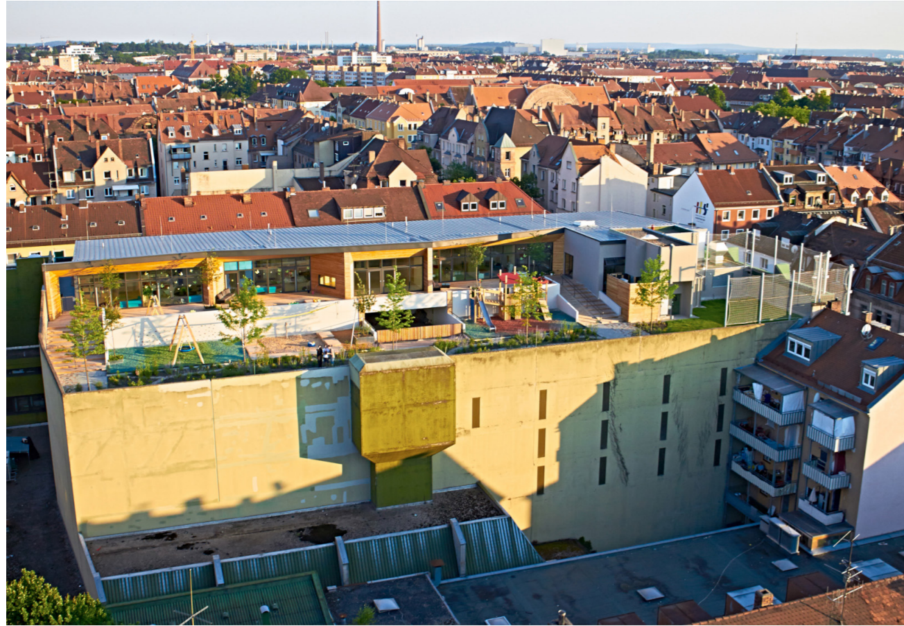
Abb. 19 Kita Wolke 10 © querwärts Architekten
