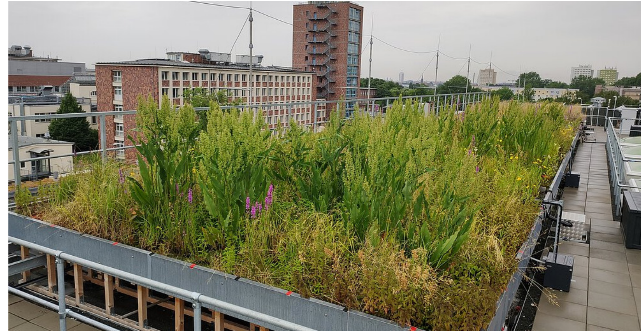
Abb. 52 Sumpfpflanzendach © Ingenieurbüro Blumberg
