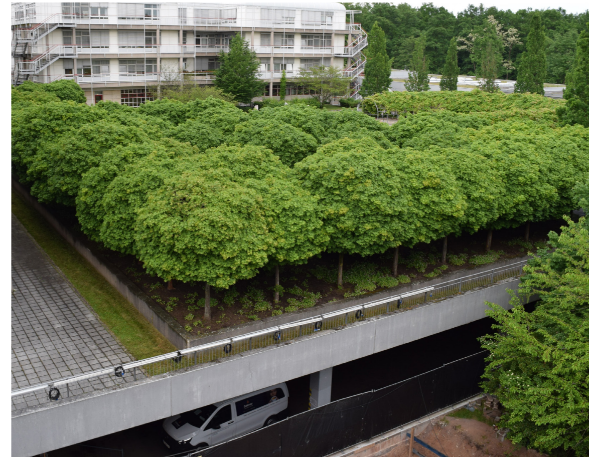
Abb. 53 Dachwald auf der Tiefgarage des Klinikum Nürnberg Süd © BuGG Bundesverband GebäudeGrün e. V.
